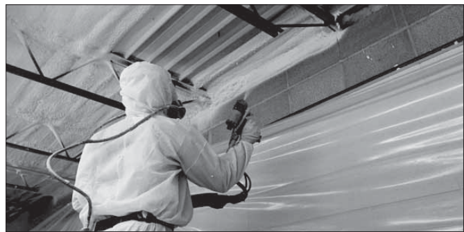
تصویر ۱ - استفاده از مواد پاششی برای ضد حریق نمودن سازه‌ها
