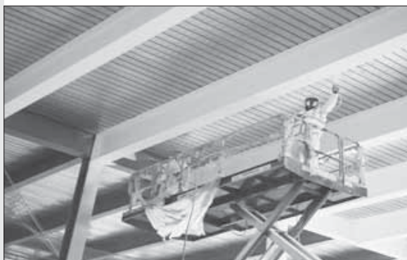
تصویر ۲ - تاثیر تصویربرداری پروفیل‌های فولادی در تعیین ضخامت پوشش ضد حریق اسکلت فلزی
