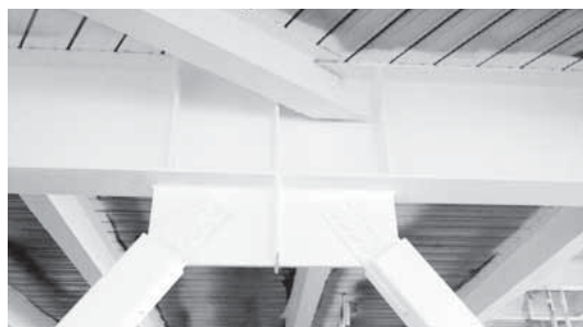
تصویر ۴ - استفاده از رنگ ضدحریق منبسط شونده به عنوان پوشش ضدحریق در سازه
