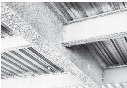
تصویر ۳ - استفاده از پوشش ضدحریق بر پایه مواد معدنی پاششی
