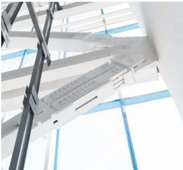
▼ استفاده از میراگر اصطکاکی در برج ۱۸۰ متری اداری به منظور محافظت از جان و سرمایه
