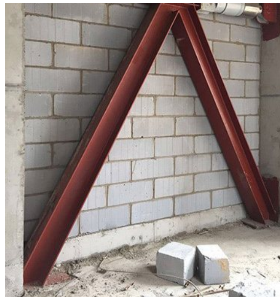
▼ به کارگیری میراگر ویسکوز در مقاوم سازی ساختمانی تجاری در چین
