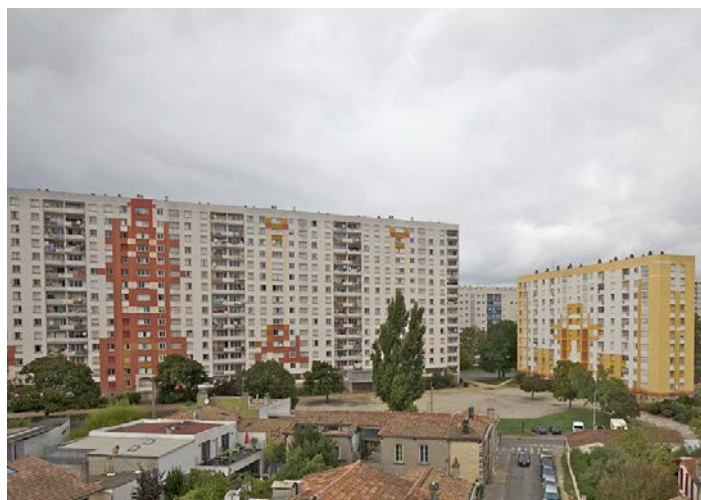
پیش از بازسازی و نوسازی ▼
