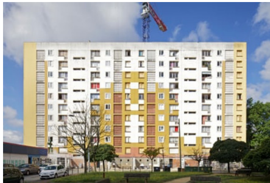
قبل از بازسازی و نوسازی ▼
