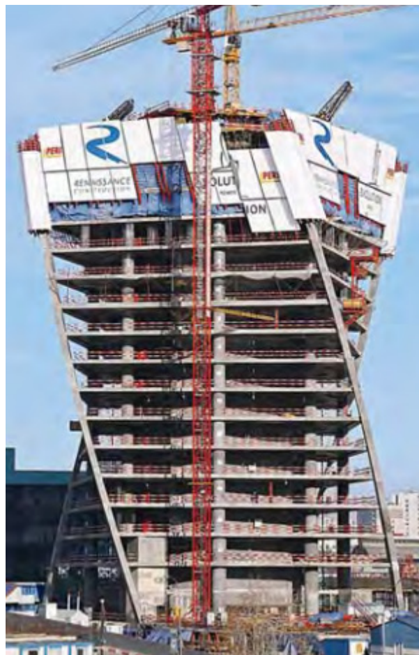
واحد پانل حفاظت RCS محصور شده در سه کارخانه برتر در دست ساخت.
