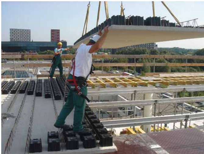
برخی از انواع قالب‌های سیستم دال مجوف
