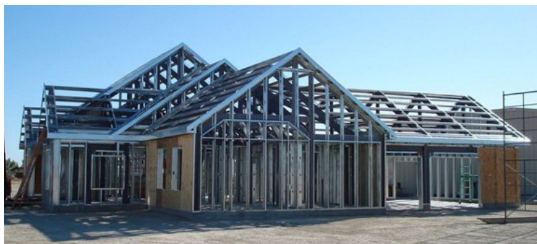
تصویر ۳: نمونه ای از ساختمان با سیستم LSF
