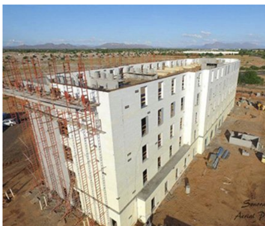
تصویر ۹: ساختمانی ۵ طبقه با استفاده از سیستم ICF
