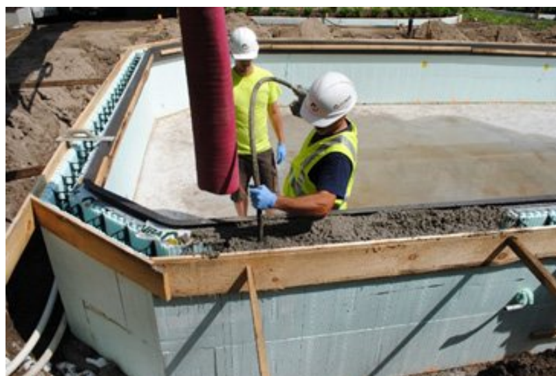
تصویر ۷: بتن ریزی در سیستم ICF
